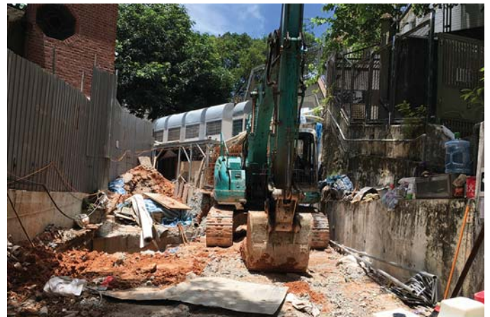
正在進行的強化擋土牆工程
