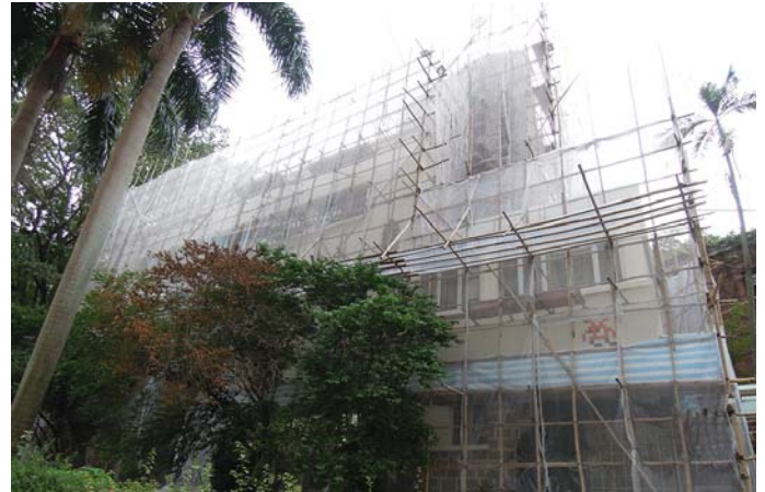
2015年進行利黃瑤壁樓外牆全面維修工程
