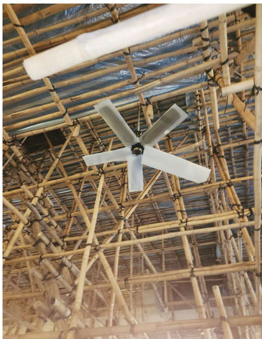
自資工程部份包括吊扇及吊燈加裝鋼索，以增加安全性
